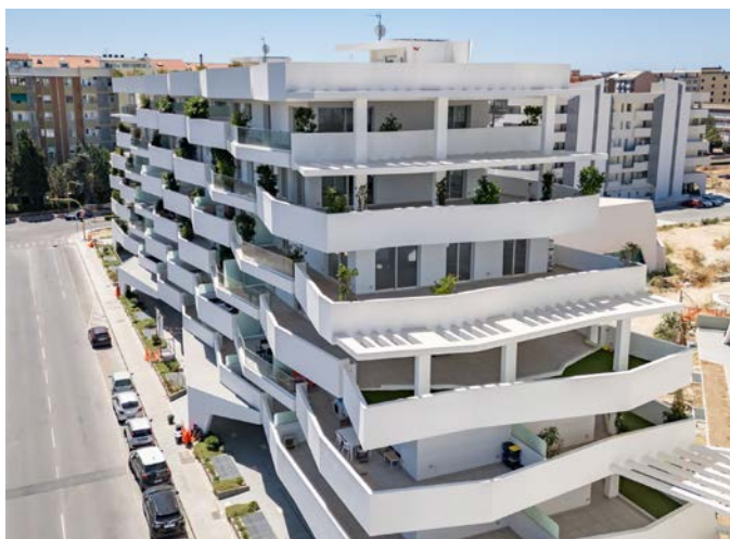
Oliveto Complex - Cagliari (Italia)
